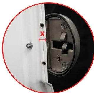
**MESUREZ X = PARTIE PLANE DE LA TÔLE**
